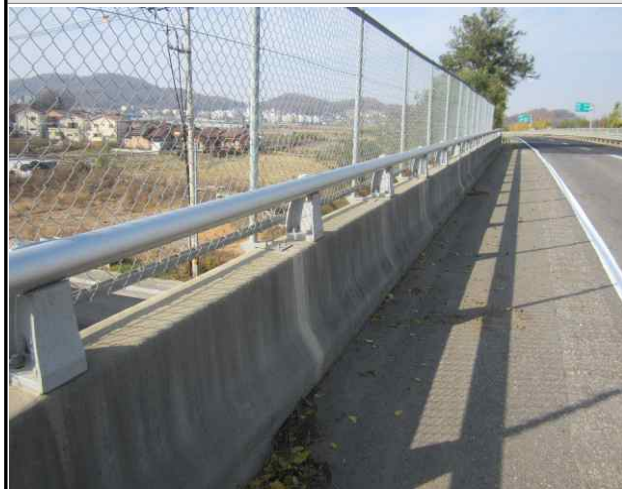
난간 및 연석 전경
